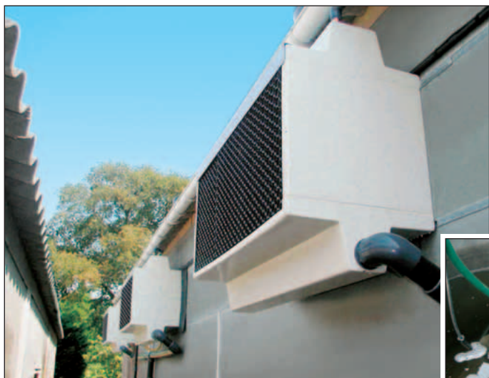
Система охлаждения Coolbox в сочетании с центральным коридором
