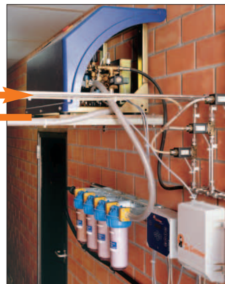
Центральный насос с четырехступенчатым фильтром
