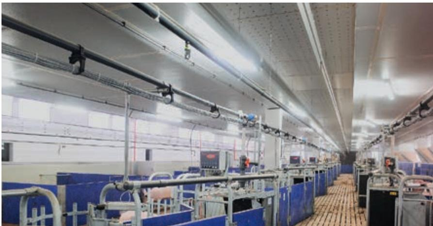
Подача приточного воздуха по перфорированному каналу зоны ожидания для свиноматок с кормлением по вызову
